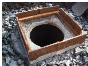
kladenie šachtových rámov, dažďových vstupov a ostatných armatúr v komunikáciách
